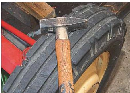
**Bild 1.24** Holzstiele, die in einer Metalltülle am Hammerkopf befestigt sind, können am Rand der Tülle leicht brechen. [13]
